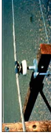
图 F01-2 预绞式短护线条
