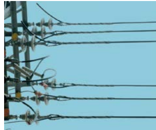
耐张线夹用于绝缘导线
